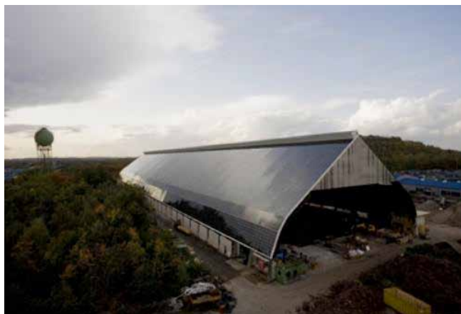
Thin film dak bedrijfspand, Moers
