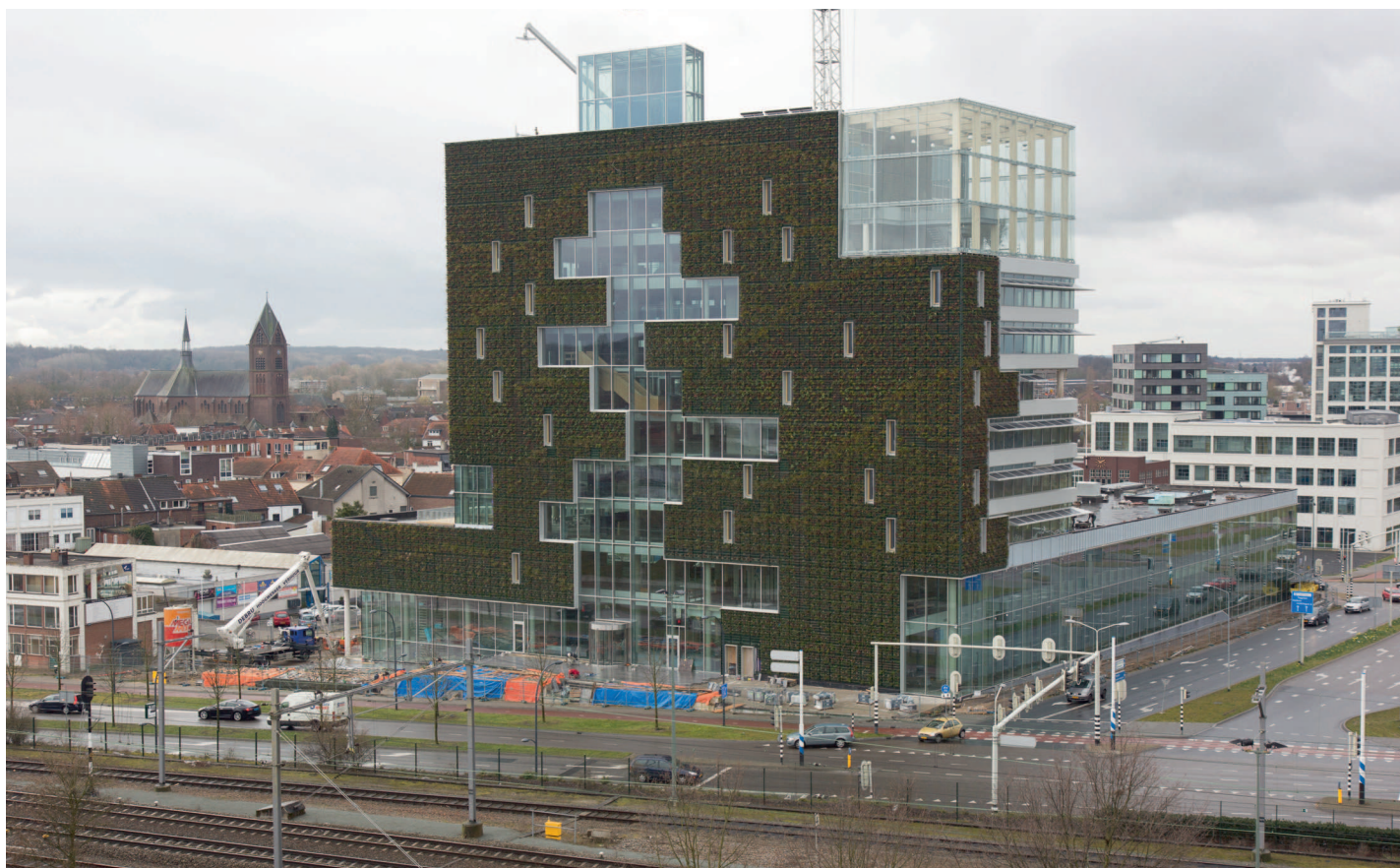
Het stadskantoor Venlo, waarin velerlei Cradle-to-Cradle-oplossingen zijn verwerkt.
